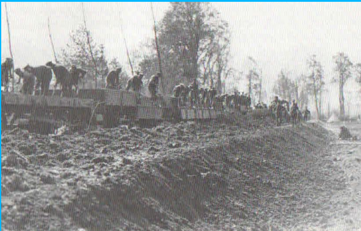
Figura 6 – Construção de estrada de ferro
