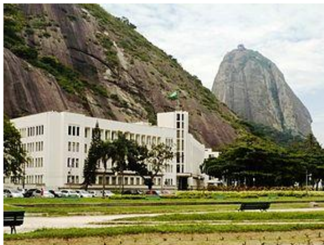
Fig. 19 Escola de Comando e Estado-Maior do Exército
