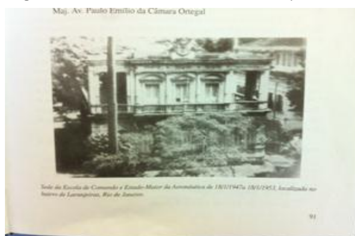
Figura 20 Prédio da ECEMAR à Rua das Laranjeiras, 192.
