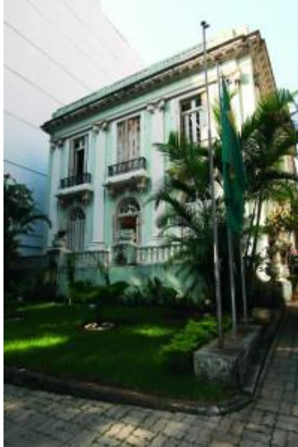
Figura 21 Prédio da ECEMAR à Rua Pereira da Silva
