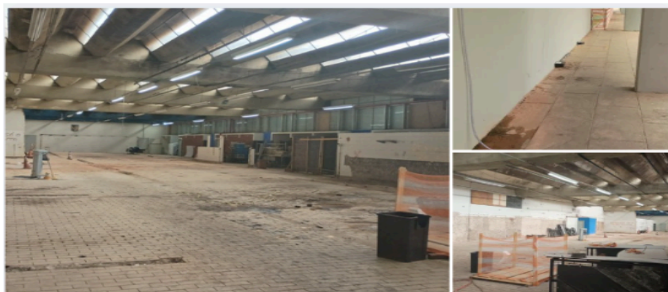
Figura 2 Fotografias das obras realizadas nos refeitórios do Corpo de Cadetes
