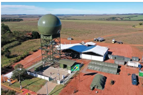
Figura 2 Estação Radar de Ponta Porã
