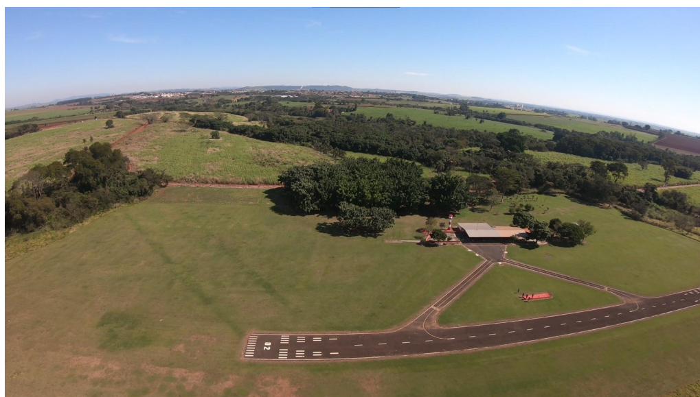
Figura 20 Imagem produzida pelo VANT ao enquadrar o waypoint 15 do plano de voo Fonte: elaboração própria baseada em captura de vídeo da GoPro.
