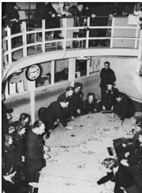
Figura 5 “Filter Room” no Quartel General da RAF em Bentley Priory - UK
