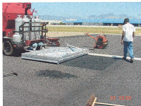
Figura 13: Reparo na pista de pouso do Galeão Fonte: Autor
