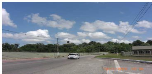
Rodovia Artur Bernardes (parte da frente do imóvel)
